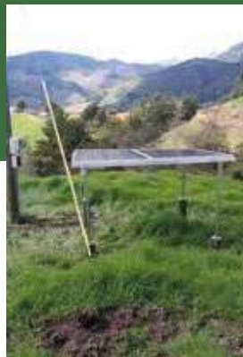
Panel Solar, Predio La Samaria, La Unión
